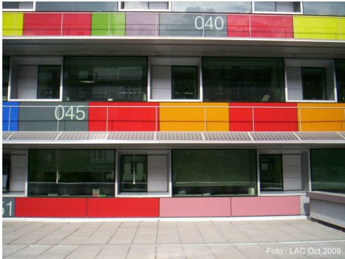
Figura 9: Edificio público INE, Madrid. Fachada Sur con placas fotovoltaicas en alero, integradas a la arquitectura.
