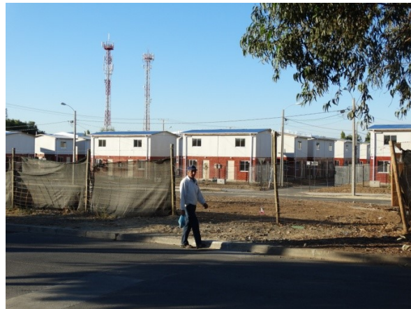
Foto 2. Conjunto Villa el Parque.
