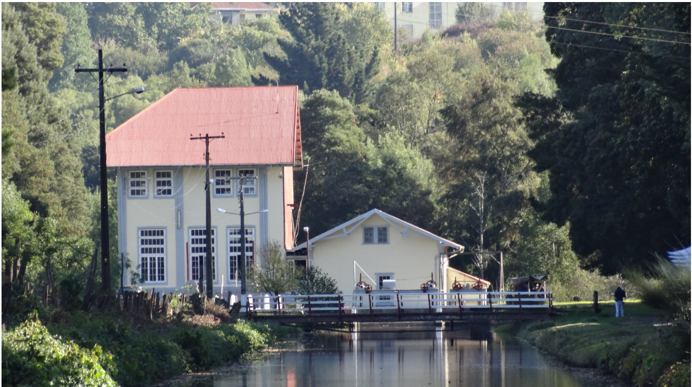
Figura 1: Bien inmueble patrimonial. Fachada poniente Central Hidroeléctrica Llolehue.
